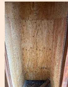
壁全体を構造用合板で 強化し耐震性を高めます
