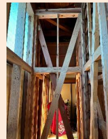
建物の主要部分となる 壁に筋交いを入れます
