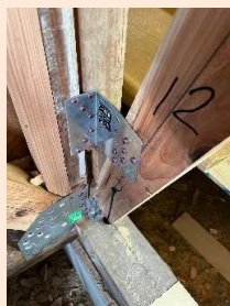
柱と筋交いを 接合金物で固定します
